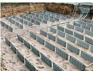
Verlegebeispiel im Komplett-Aushub (auch im Grabenaushub möglich)
