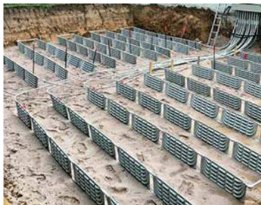
Verlegebeispiel im Komplett-Aushub (auch im Grabenaushub möglich)
